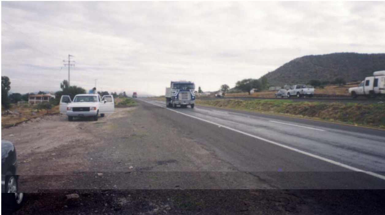
Figura 5.33 Condiciones de la carretera
