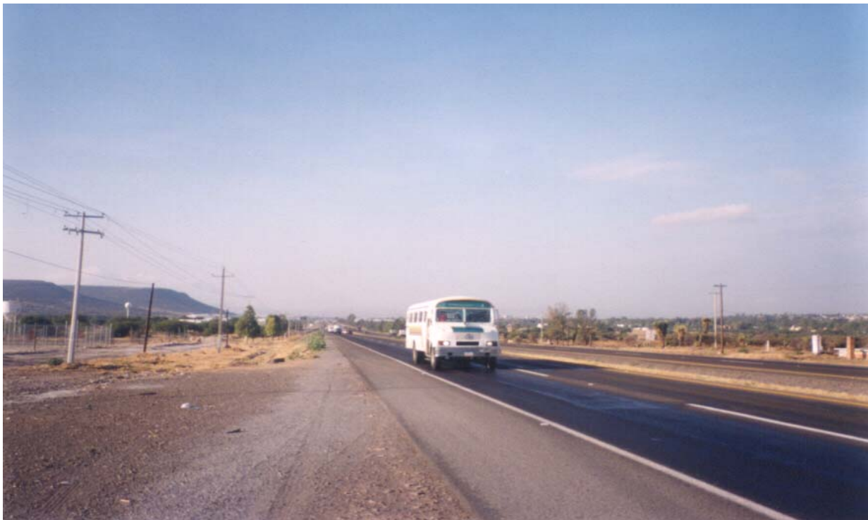
Figura 5.18 Condiciones de la carretera
