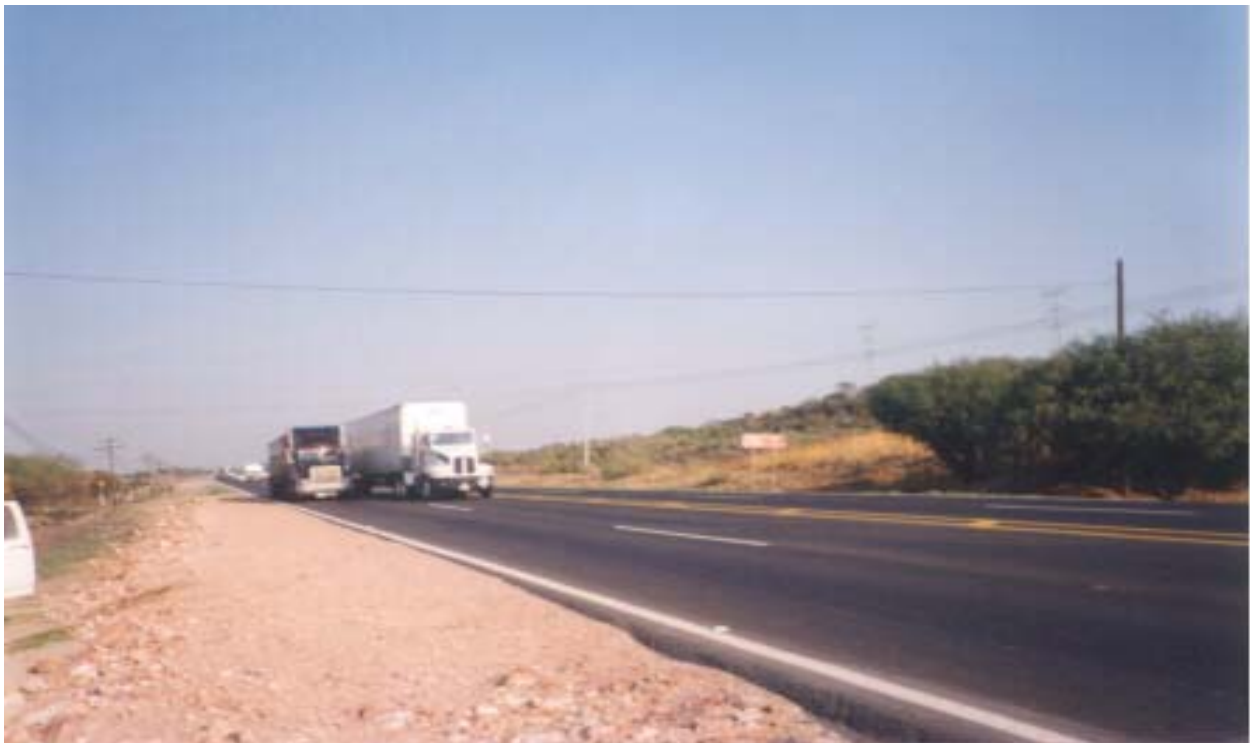
Figura 5.27 Condiciones de la carretera
