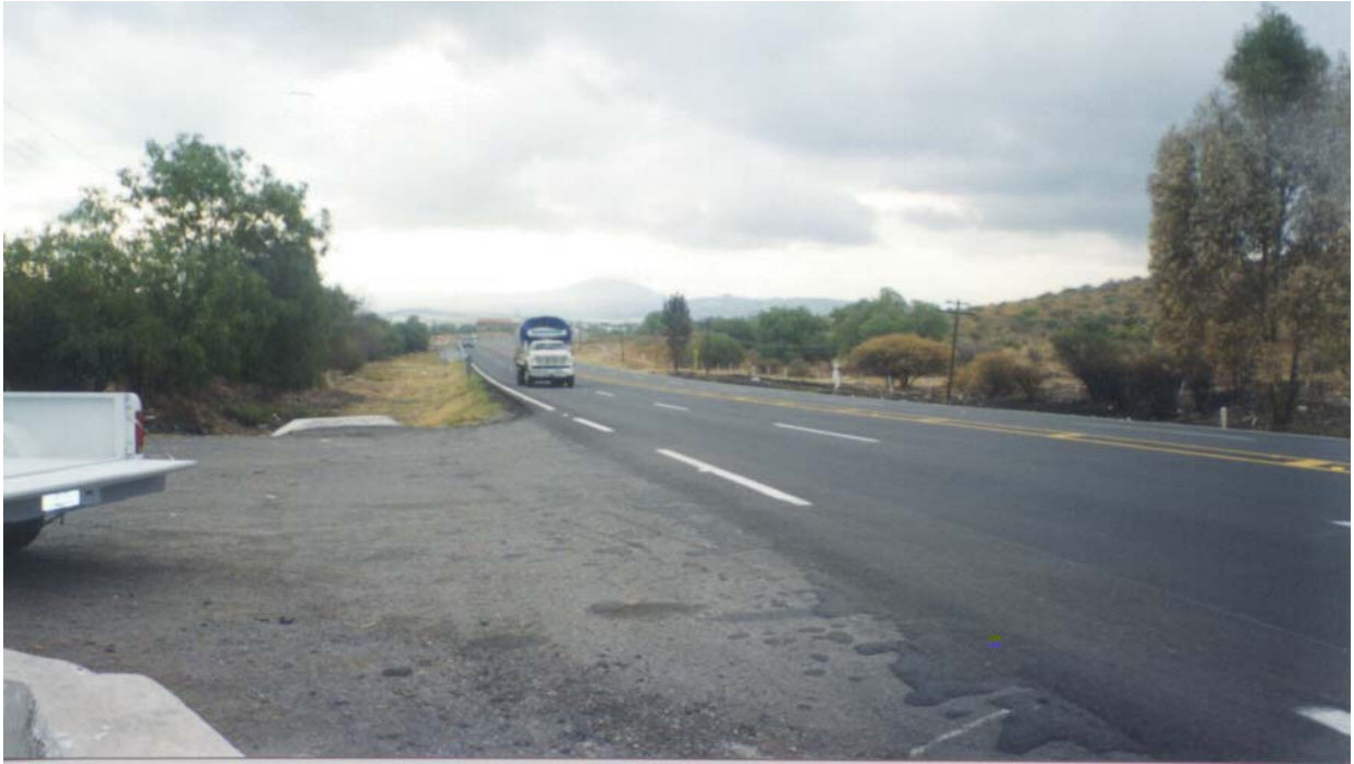
Figura 5.24 Condiciones de la carretera
