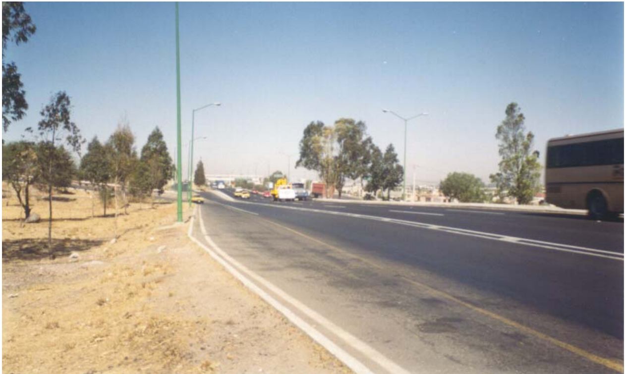
Figura 5.5 Condiciones de la carretera
