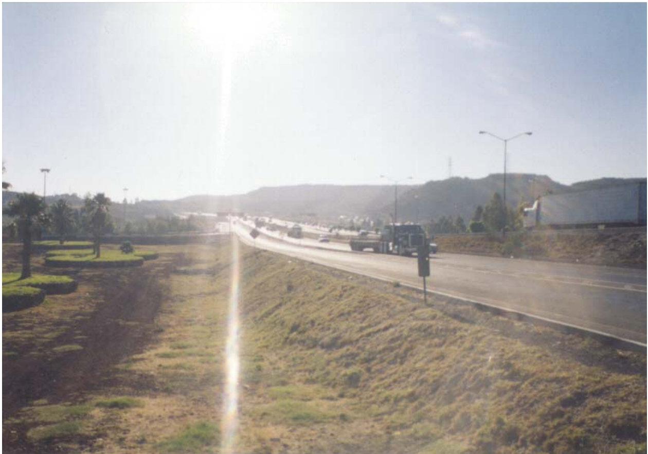
Figura 5.8 Condiciones de la carretera
