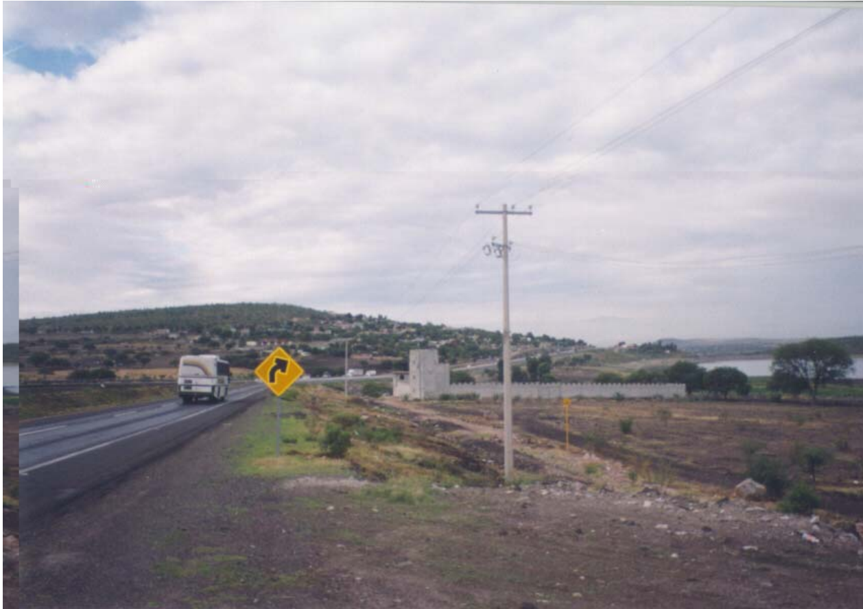
Figura 6.2 Tramo en descenso con curva cercana
