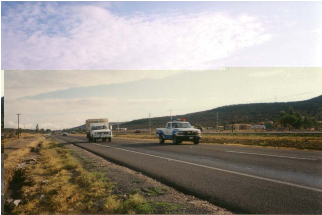
Figura 5.21 Condiciones de la carretera
