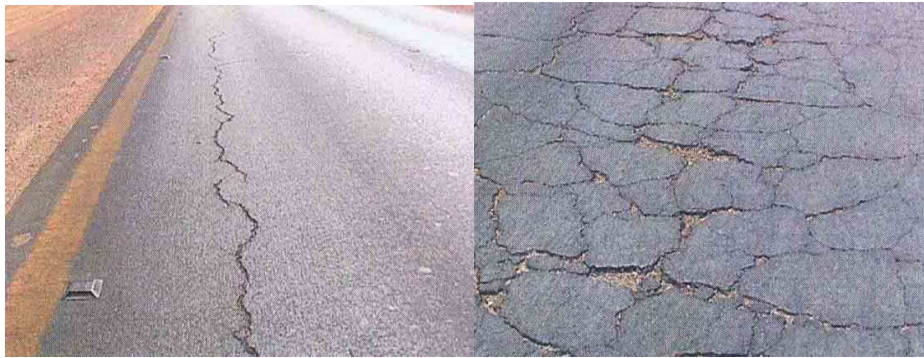
Figura 5-3 Agrietamiento por fatiga
