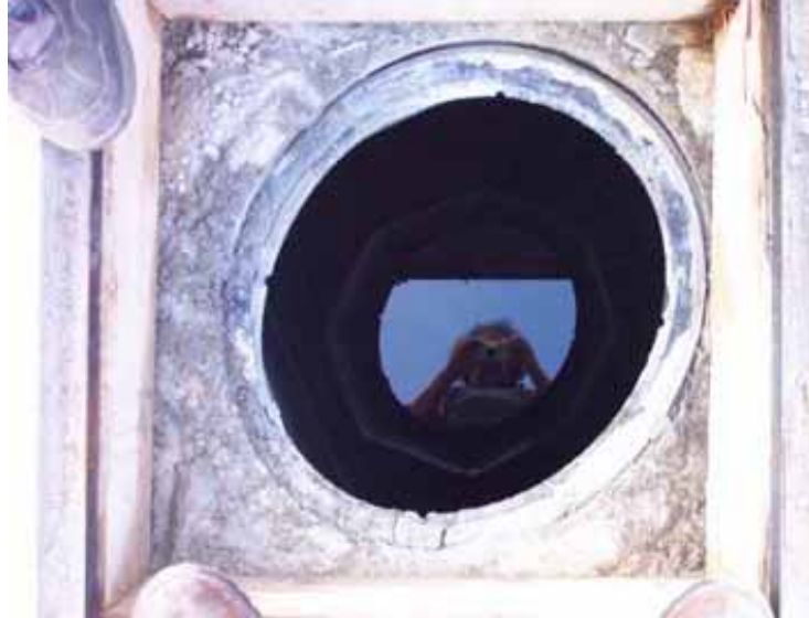
Fig 2.8. Elipsoide de deformación por el empuje resultante en una cisterna
