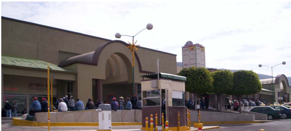
Figura 3.1 Vista del acceso al edificio Terminal de la TAQ.
