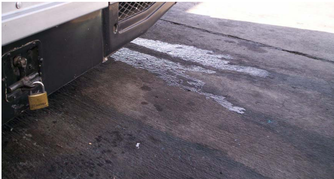
Figura 5.3 Derrame de hidrocarburos en la zona del ATF
