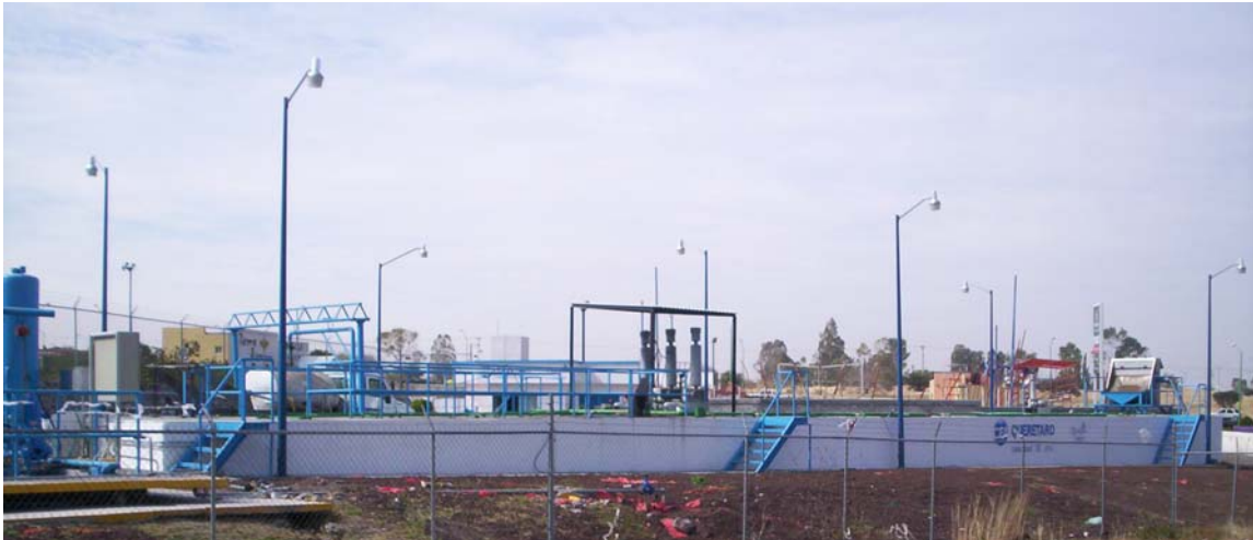
Figura 5.2 Planta de tratamiento de la TAQ
