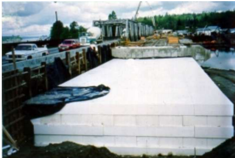
Figura 1.19. Relleno en la aproximación de un puente (Carretera 7 en el Río Stave, British Columbia, Canadá). El acomodo permite que el material actúe como una masa homogénea.
