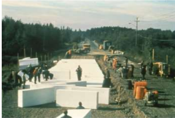
Figura 1.4. Primera capa de los bloques EPS geofoam (foto de la referencia: http://www.betong.net/ikbViewer/Content/823050/02-Refsdal-The%20First%20Geoblock%20Fill.pdf )
