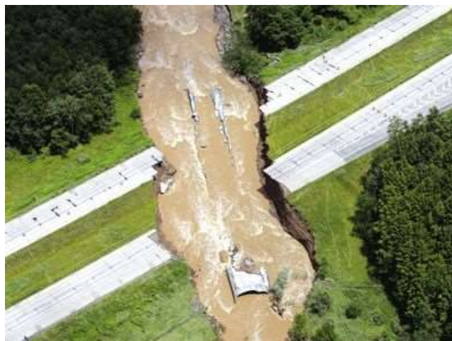
Figura 1.21. Colapso de una alcantarilla en la carretera I88, junio 2006 (foto tomada de http://www.constructionequipmentguide.com/Record-Rainfall-Destroys-Section-of-New-Yorks-I-88/7191/ )
