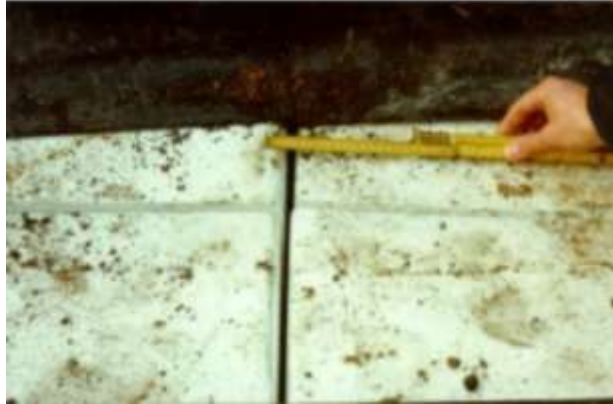
Figura 1.18. Movimiento horizontal que dio como resultado un vacío de aproximadamente 20 mm entre bloques de EPS.
