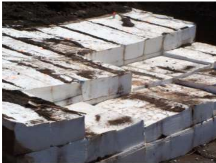
Figura 1.22. Boques de EPS después de retirar el pavimento, suelo y geotextil
