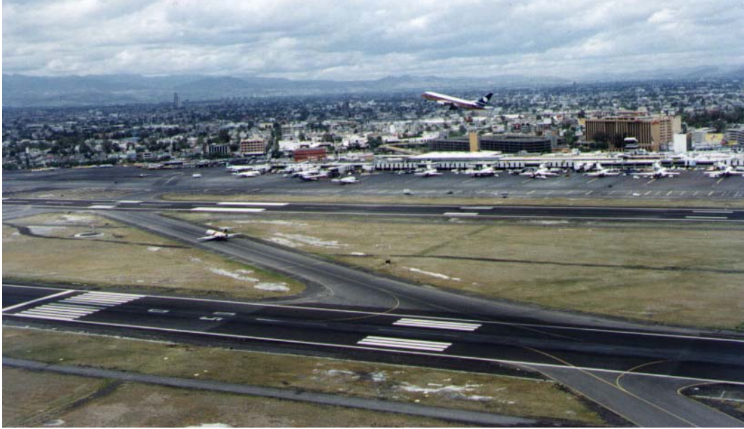
Figura 2.1. Vista parcial del Aeropuerto Internacional de la Ciudad de México.
