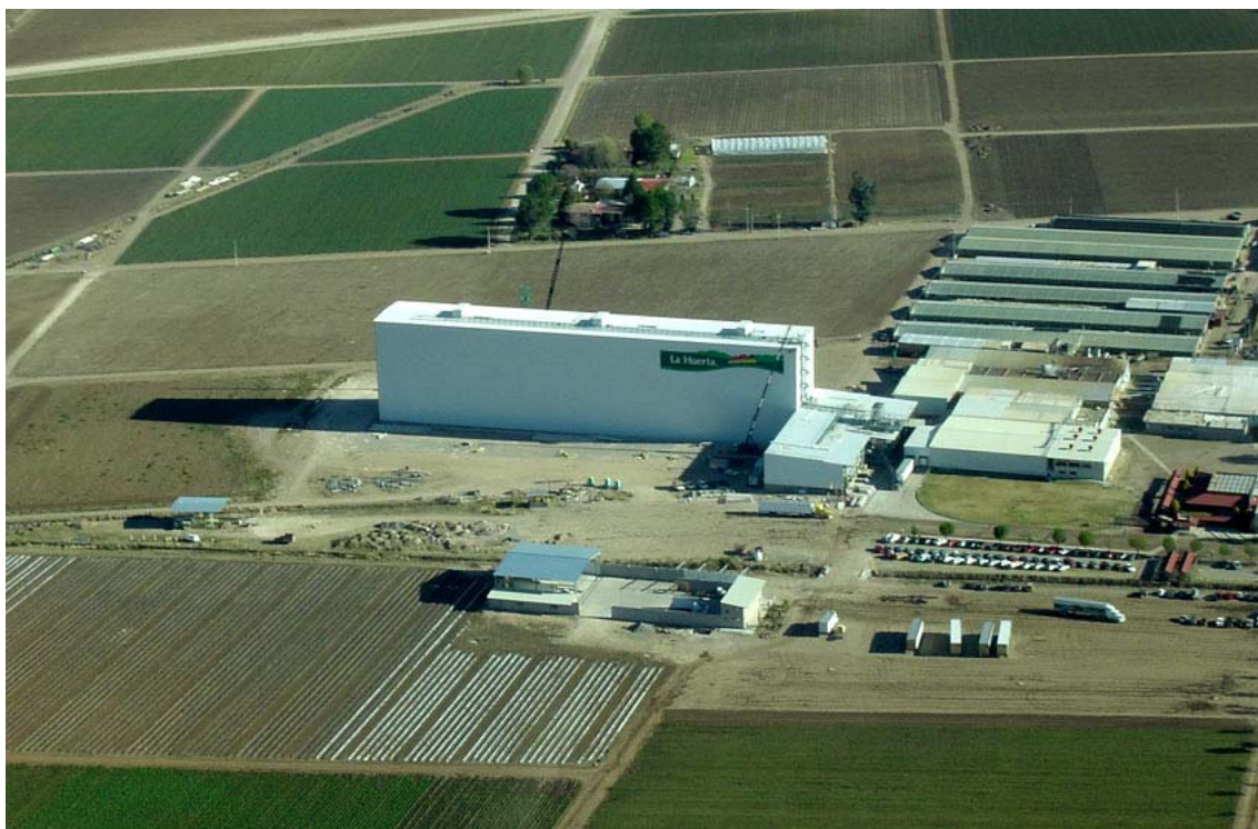
Figura: 6.1 Vista del Centro Logístico
