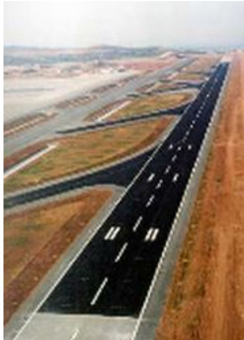
Figura 5.5 Pista del nuevo Aeropuerto Internacional de Atenas con tratamiento antipatinaje
