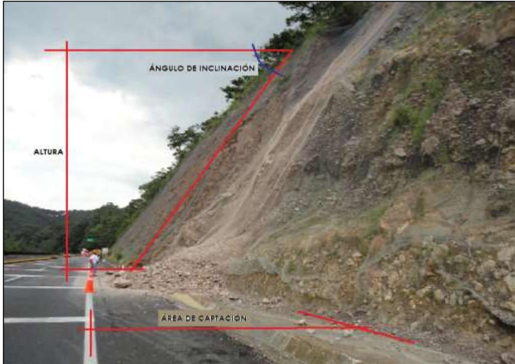
**Imagen 3.2** Principales dimensiones geométricas del talud de corte.
