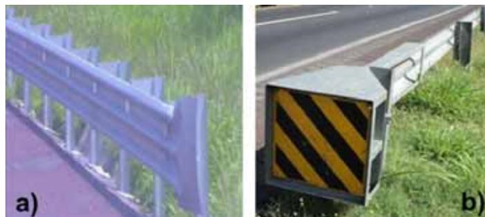
**Figura 3.34 Terminaciones de barrera metálica**
