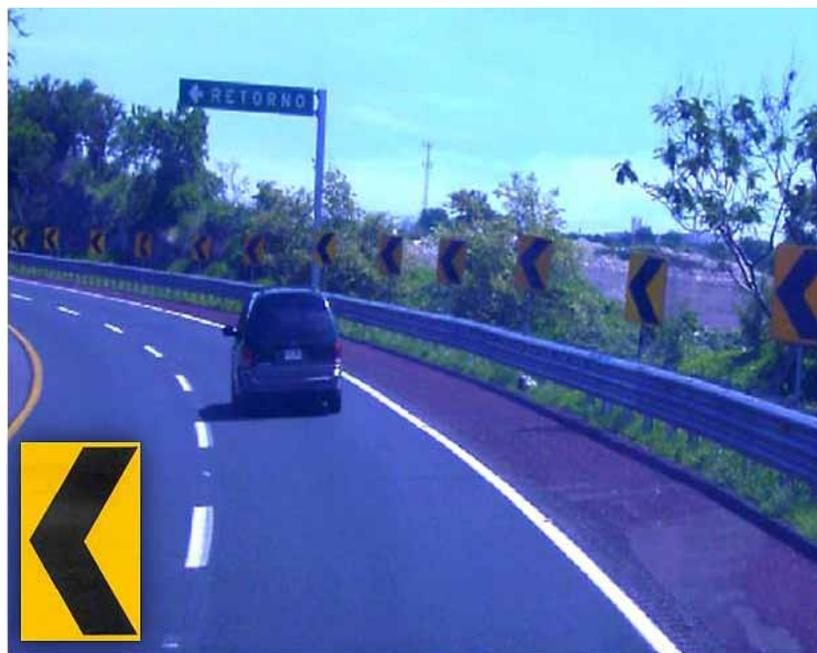
**Figura 3.35 Dispositivo indicador de curva peligrosa**
