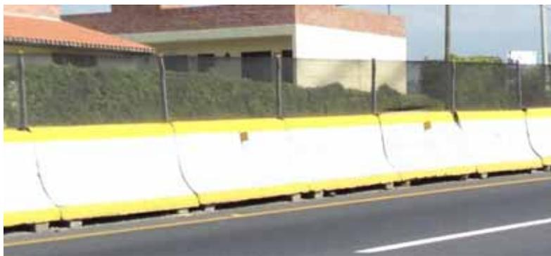
**Figura 3.31 Barrera New Jersey instalada en el tramo**
