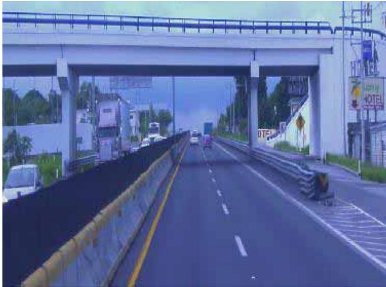
**Figura C.19 Amortiguador en pila de puente km 104+267, dirección a Cuernavaca**
