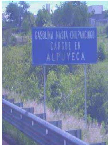
**Figura C.5 Señal Informativa ilegible a la distancia y color incorrecto<sup>9</sup> en km 110+392, dirección a Acapulco**
