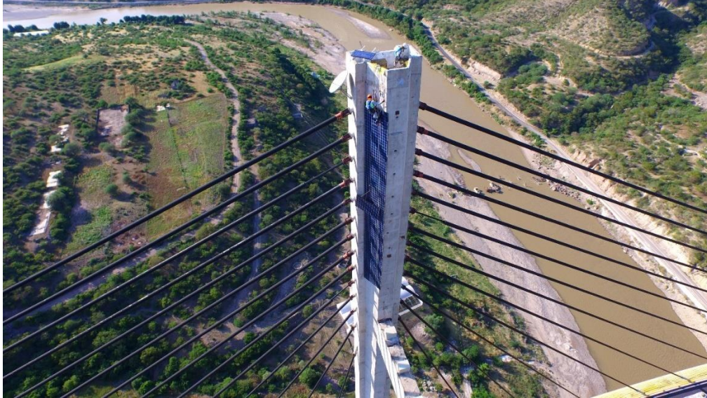
Figura 2.3. Paneles solares del puente Mezcala
