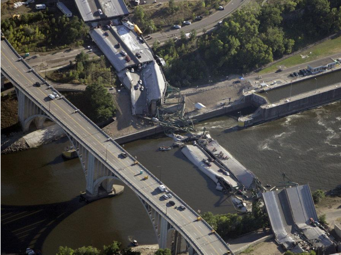
Figura 1.1. Colapso de puente vial I-35W en Minneapolis, USA.
