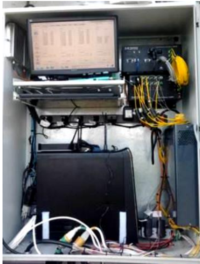
Figura 1.4. Gabinete de control del puente Río Papaloapan
