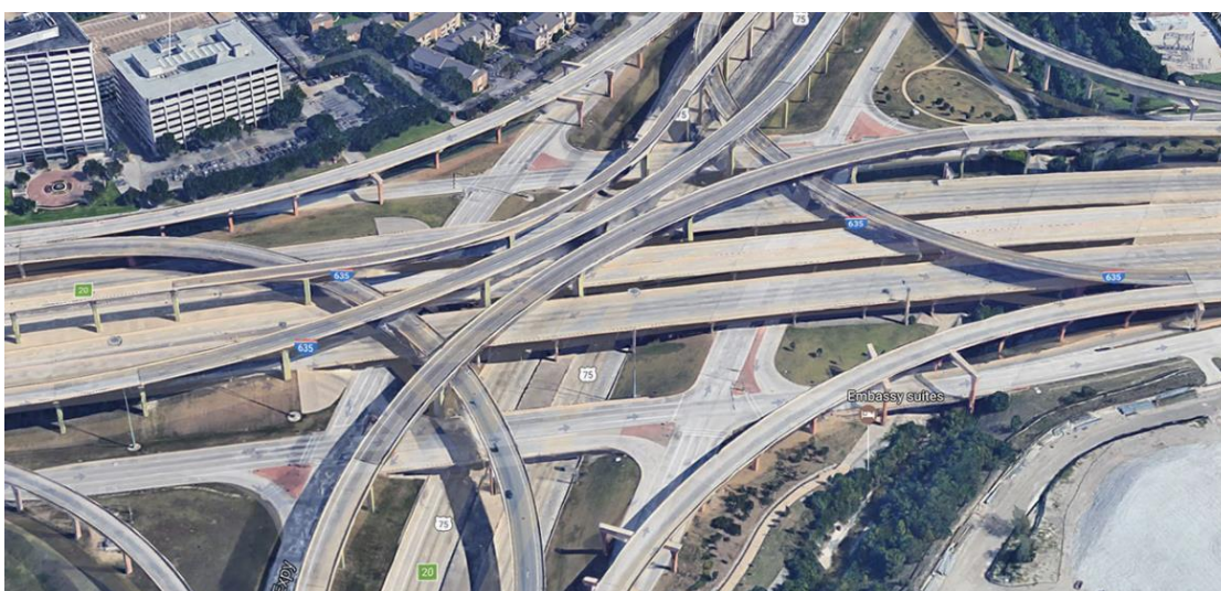
Figura 2.8. Ejemplo de una intersección a desnivel
