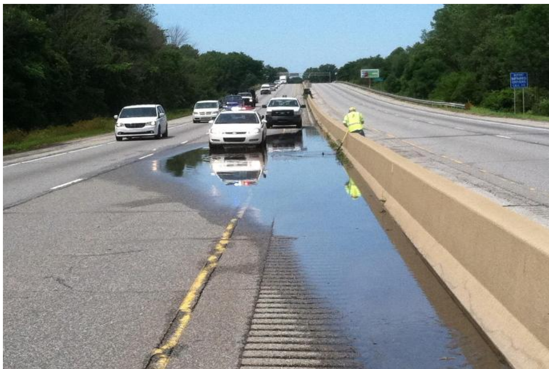
Figura 2.5 Encharcamiento debido a problemas en el drenaje
