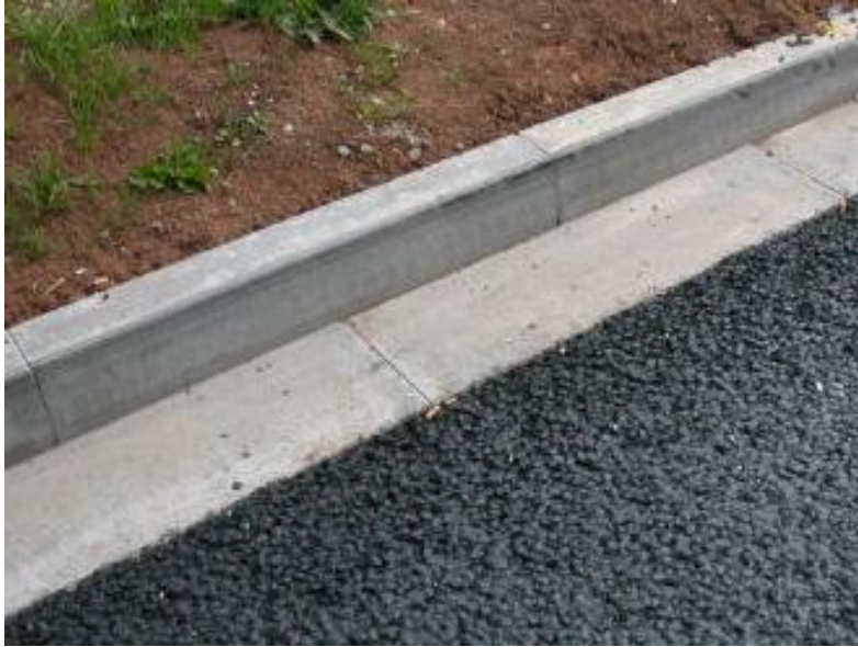
Figura 2.18 ¡Error! No se encuentra el origen de la referencia.. Detalle de guarniciones de perfil vertical
