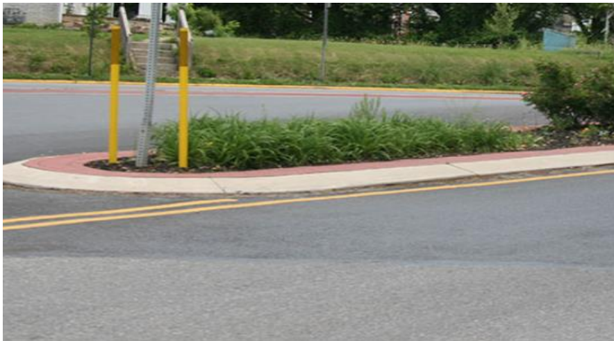
Figura 2.19. Intersección canalizada con guarnición de perfil bajo
