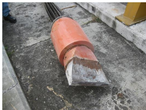
Figura 1.1 Elemento de anclaje del tirante 1, semi-arpa 5 que falló.
