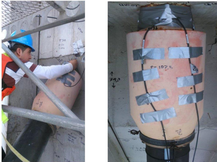
Figura 1.15 Procedimiento de colocación y fijación de sensores
