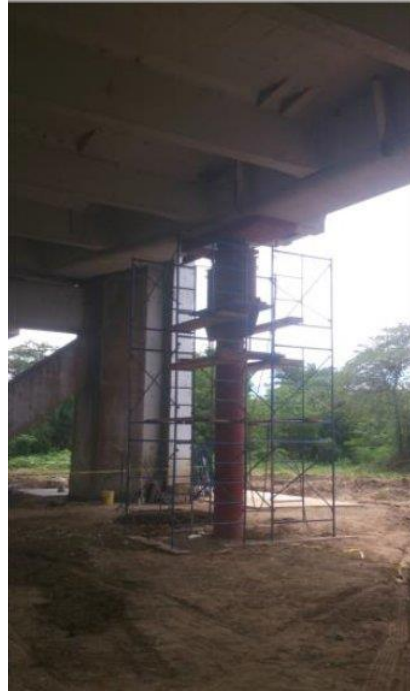
Figura 1.8 Puntal de refuerzo temporal en la zona afectada por la falla
