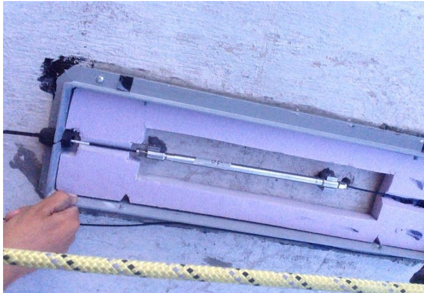
Figura 1.5 Extensómetro instalado en torre
