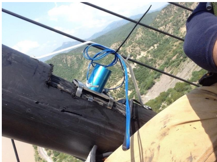
Figura 1.2 Acelerómetro instalado en tirante de sujeción del puente Mezcala
