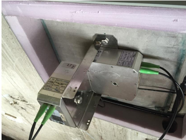
Figura 1.3 Inclinómetro instalado en estribo del puente Mezcala
