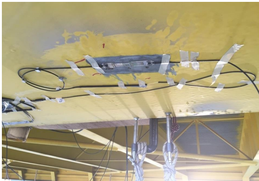
Figura 1.4 Extensómetro instalado en la viga principal
