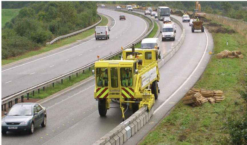
Figura 3.34 Barreras de concreto móviles.
