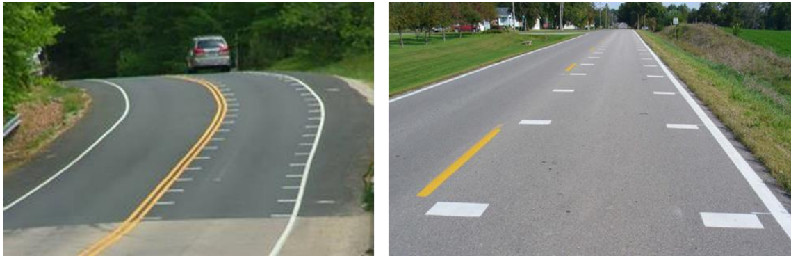
Figura 3.31 Marcas provisionales en el pavimento.
