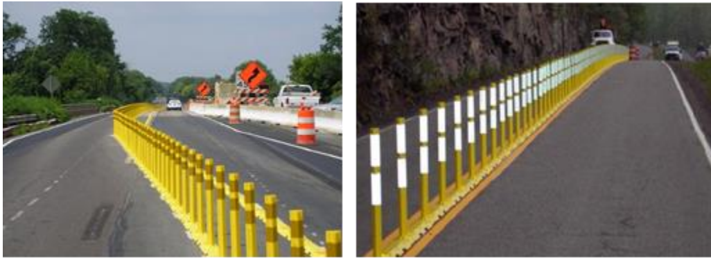
Figura 3.25 Dispositivos para separación de sentidos de circulación.
