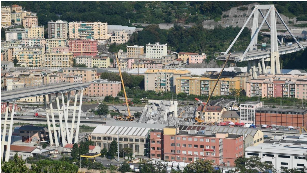
Figura 0.2. Puente Morandi colapsado en Génova, Italia, el 14 de agosto de 2018.
