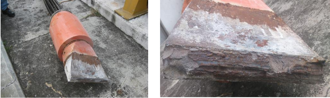
Figura 1.4. Falla en elemento de anclaje del tirante 1 semiarpa 5 (T1S5).
