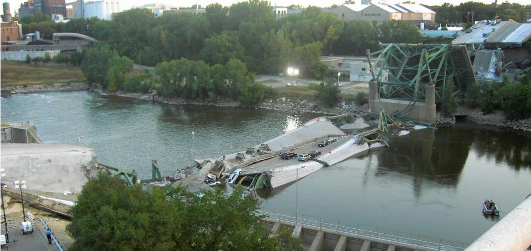
Figura 0.1. Puente 9340 visto desde arriba después del colapso en Minesota, EUA, el 1 de agosto de 2007.
