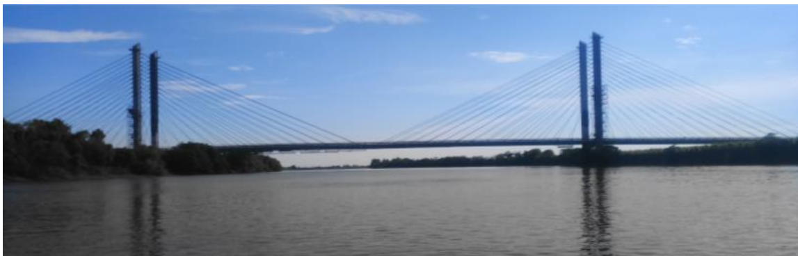
Figura 1.1. Puente Río Papaloapan.
