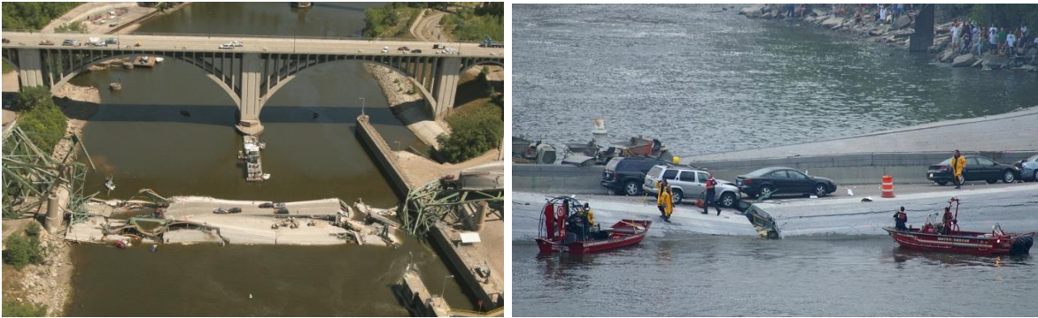
Figura 0.4. Colapso del Puente 9340 en Minnesota, EUA el 1 de agosto de 2007.
