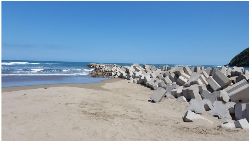
Figura 1.10 Sitio donde se construyen los cubos ranurados, para la construcción de la escollera
