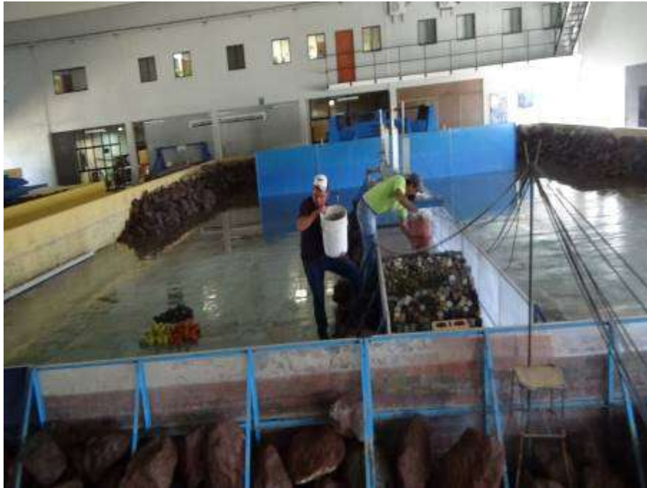
Figura 3. 4 Vaciado de grava para construcción de la pendiente del modelo hidráulico.
