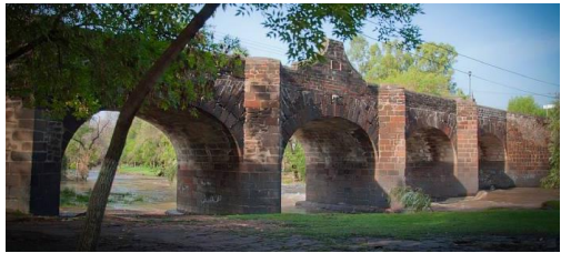
Figura 1.19 Puente de Piedra
