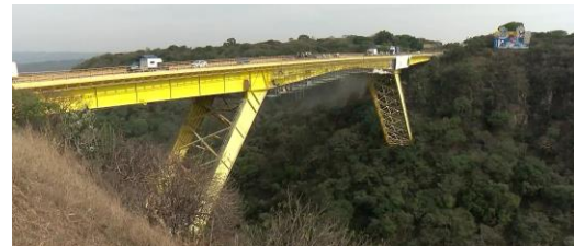
Figura 1.14 Puente Fernando Espinosa
