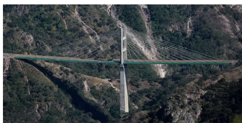
Figura 1.5 Puente El Carrizo
