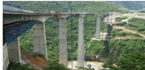
Figura 1.10 Puente San Marcos
