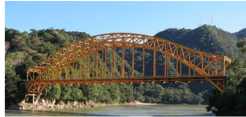
Figura 1.17 Puente Boca del Cerro
