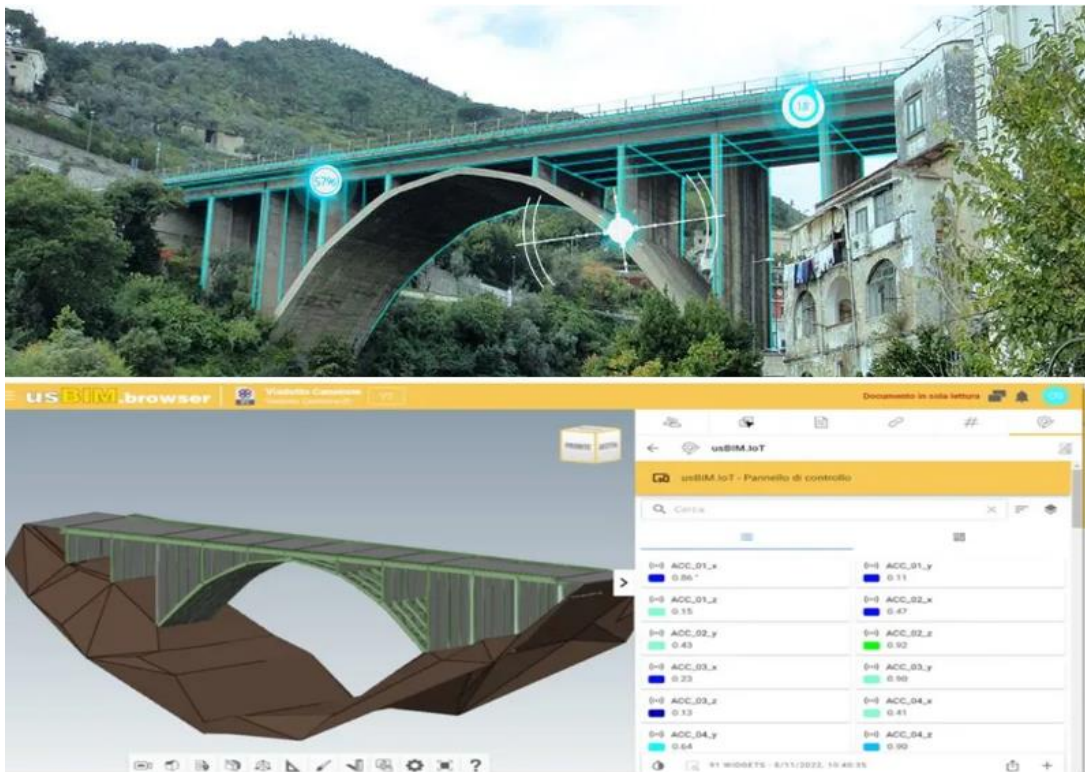
Figura 3.6 Monitoreo de puentes con una plataforma BIM IoT
