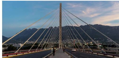
Figura 1.9 Puente de la Unidad
