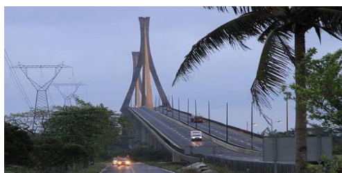
Figura 1.4 Puente Dovalí Jaime
